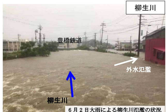
6月2日大雨による柳生川氾濫の状況 流域治水の本格的展開による再度災害防止対策及び事前防災対策の推進
